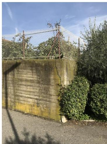
Particolare della lesione sullo spigolo SE del muro perimetrale
