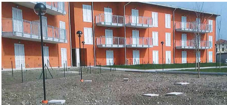
2021 - cantiere ATC a Ivrea
