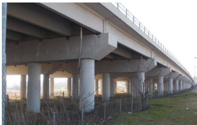
2015 – Viadotto autostradale A21
