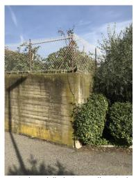
Particolare della lesione sullo spigolo SE del muro perimetrale
