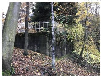
Lungo i lati E-N-NO il lotto è delimitato da un muro di contenimento. Lungo lo spigolo tra i lati E e N il muro presenta una frattura verticale molto pronunciata
